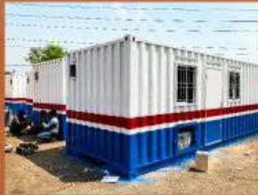
Berbagai Proyek PLTU Dalam Negeri Various PLTU Project
